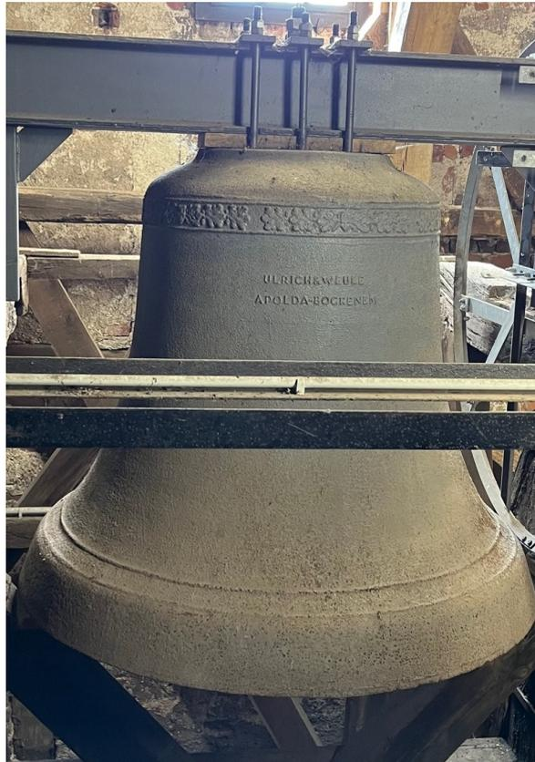
Diese Glocke an höchster Stelle der Kirche läutet nicht wie die anderen, sondern wird zur halben und vollen Stunde mit einem Hammer angeschlagen.
